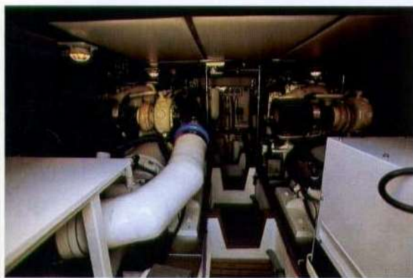
In quadrato, un'apertura a pagliolo permette di accedere alla cala motori.
